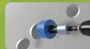
Dose anzeichnen und 74 mm Bohrloch auf der Vorderseite einbringen.
