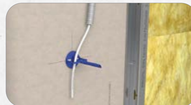
1. Klebescheibe auf Leitungsträger kleben und Schutzfolie abziehen. Leitungsträger auf Trockenwand befestigen und Leitungen oder Rohre durch Bügel führen.
