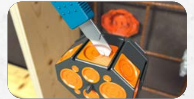
2. Membrane mit einem Cuttermesser öffnen. Großrohreführung M32.
