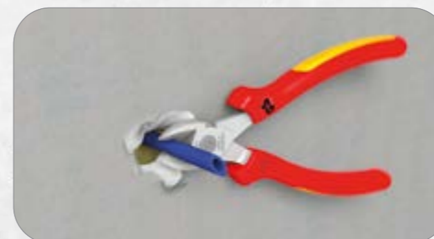
3. Leitungsträger mit Zange bündig zur Wand abzwicken.
