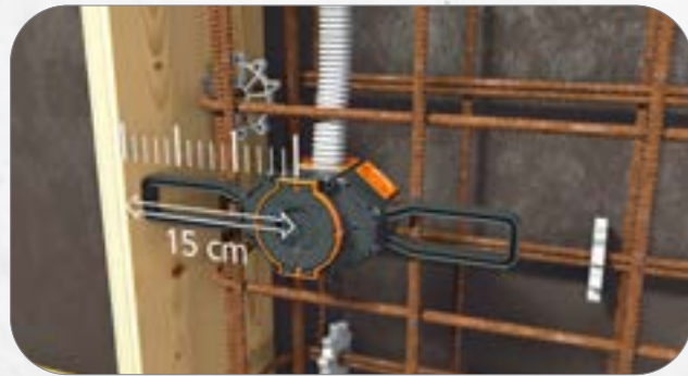
1. Flügel auf die Membrandose M1, M2 oder M3 aufstecken. Flügel geben 15 cm Normabstand zur Türschalung vor und ermöglichen eine einfache Montage. Flügel mit Draht auf der Stahlarmierung befestigen.
