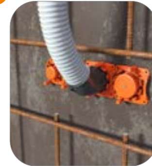
Frontteil auf Schalung nageln. Das Frontteil lässt sich durch das Stecksystem fest mit weiteren Krümmern und auch Tüllen verbinden. Krümmer auf das Frontteil stecken. Idealer Biegeradius von 30°.
