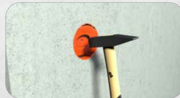
5. Nach der Betonage einfaches Öffnen durch Hammerschlag.
