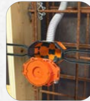
1. Variante 1: Frontteil auf Schalung nageln. Die integrierte Nagelfixierung im Frontteil ermöglicht eine einfache Montage (l). Variante 2: Aufsteckbare Flügel auf Membrandose stecken und mit Draht an Stahlarmierung befestigen (r).
