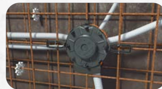
2. Membrane mit einem Cuttermesser öffnen. Werkzeuglose Kombieführung von Kabeln und (starr)en Röhren von M9-M40. Die Membrantechnik gewährt eine absolut betondichte Einführung.
